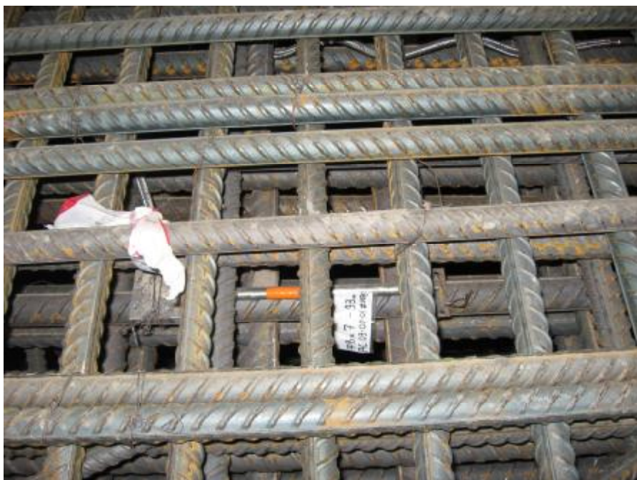
Рис. 4. Датчик деформаций готов контролировать фундамент «высотки»
