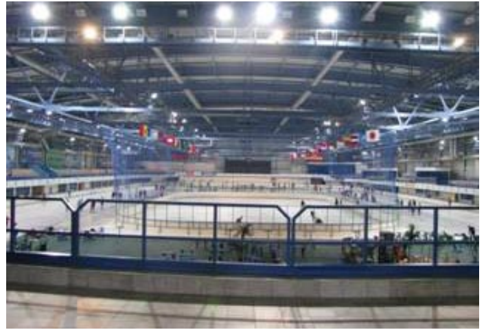
Ноябрь 2008. «Уральская молния» под контролем Системы мониторинга на базе волоконно-оптических датчиков деформаций
