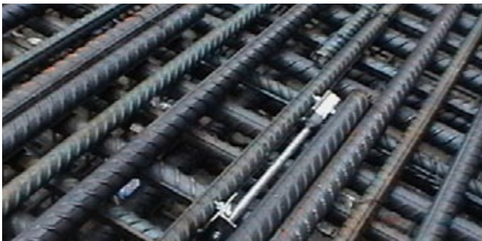
Волоконно-оптический датчик деформаций на арматуре перед заливкой бетоном
