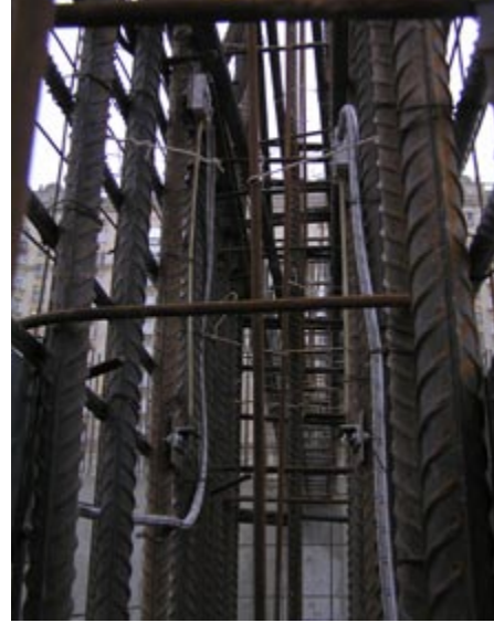
Первые датчики деформаций закреплены на каркасе пилона
