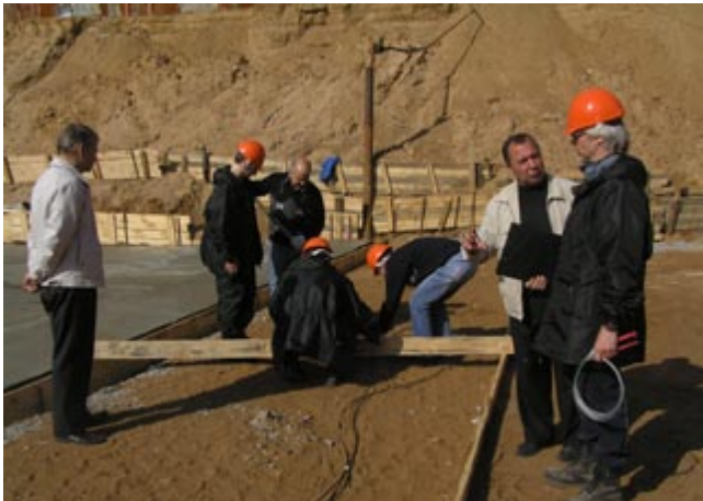
Прокладка волоконно-оптического кабеля
