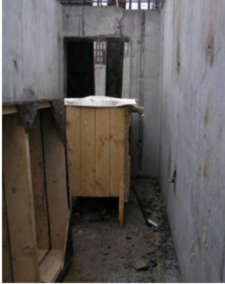
Первый временный диспетчерский пункт: здесь хранятся 25 коммутационных блоков от датчиков типа «М» и «Ф». Здесь же проводятся первые сеансы регистрации.
