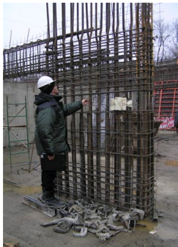
Датчики деформаций перед заливкой пилонов: проверка крепления
