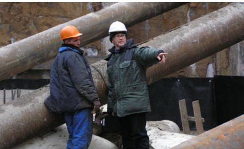
Обсуждение вопросов установки датчиков деформаций в арматуре фундамента
