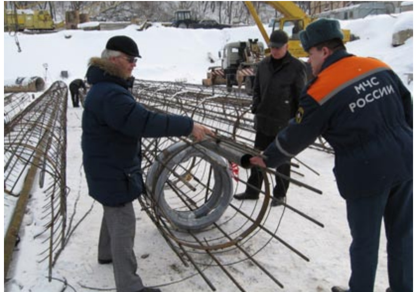
Установка датчиков деформаций ЗАО «Мониторинг-Центр» в буронабивные сваи в контакте с представителями МЧС
